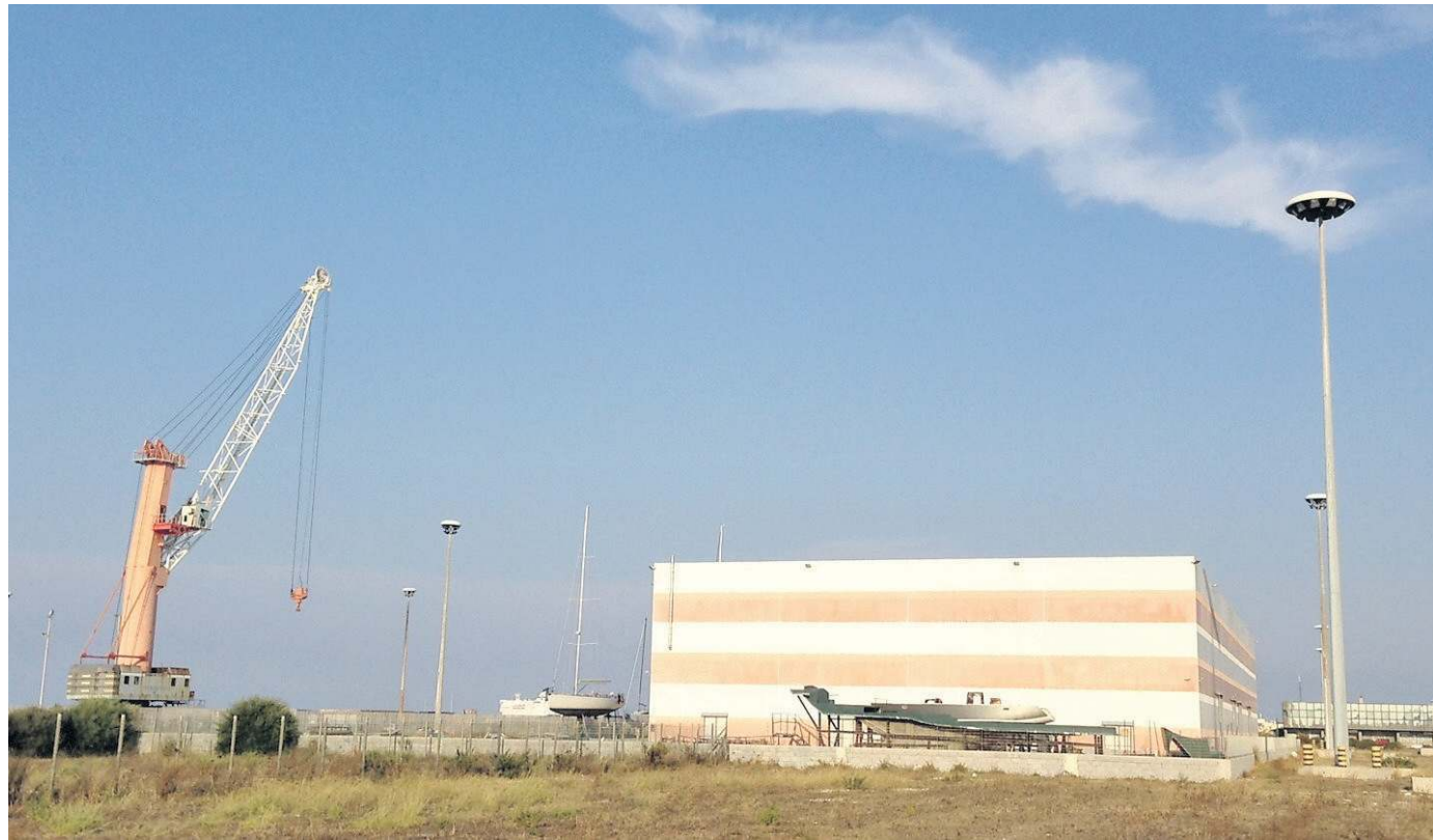
Il cantiere navale nel porto industriale che accoglierà il travel-lift
