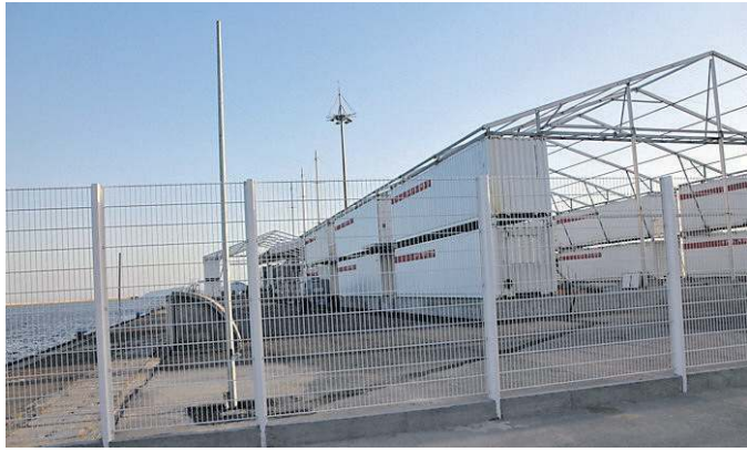
La base provvisoria di Luna Rossa al Terminal Crociere di Cagliari
