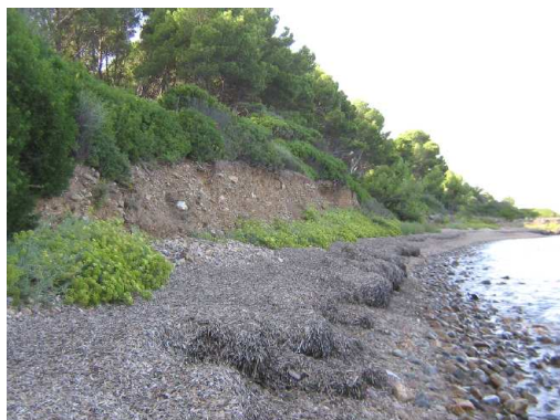
Villa d'Orri 2 - costa in erosione e ripa di erosione di 2-3 m
