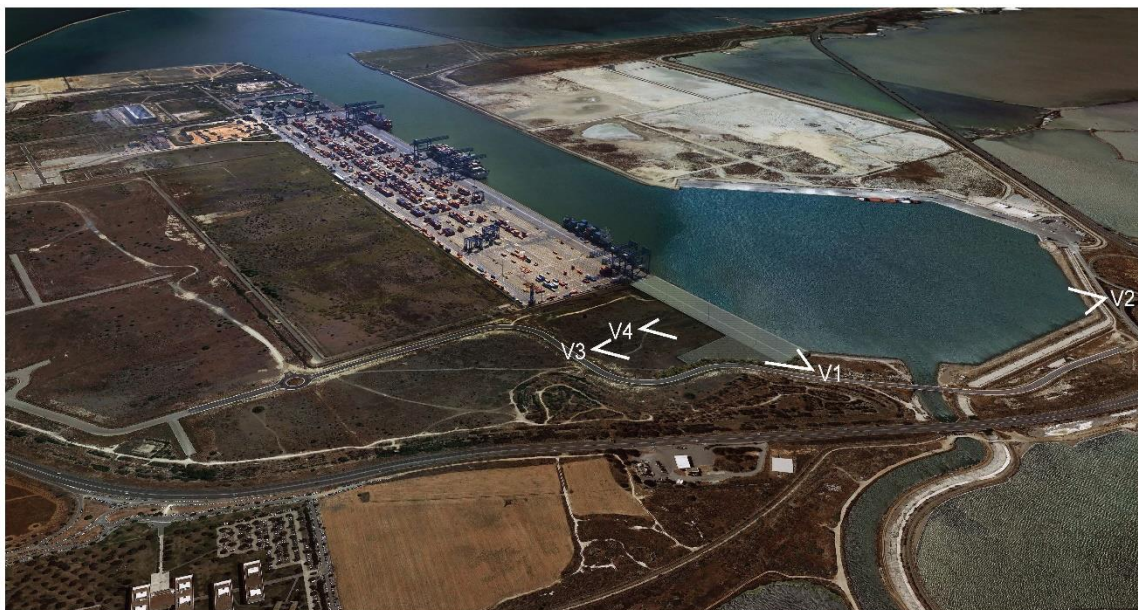
vista aerea da Nord intervento di realizzazione della nuova banchina.
