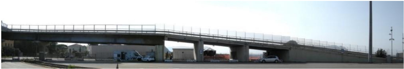
Vista rampa facciata Nord – stato attuale
