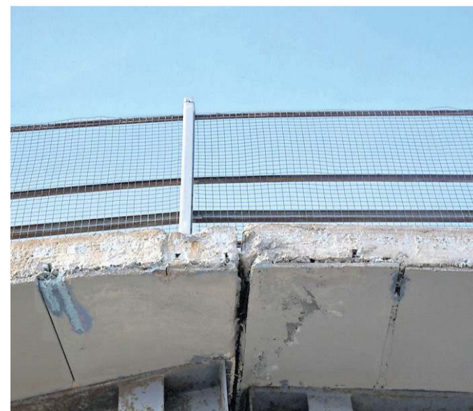
Nelle due immagini sono visibili i segni del degrado del ponte sia sulle parti di cemento sia su quelle di ferro
