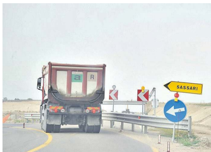
Uno dei cantieri della nuova Sassari-Olbia a quattro corsie
