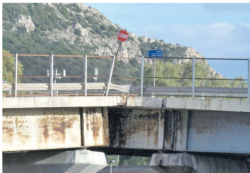
Nelle due immagini sono visibili i segni del degrado del ponte sia sulle parti di cemento sia su quelle di ferro
