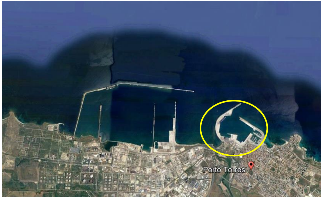
Figura 2 Dettaglio dell'Hub portuale del Porto Civico di Porto Torres (con il cerchio giallo che evidenzia l'area dove avverranno i nuovi interventi).
