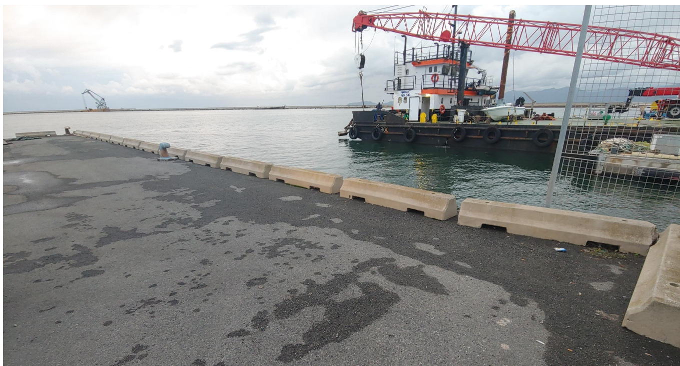
Figura 3 - Cordoli esistenti da tinteggiare
