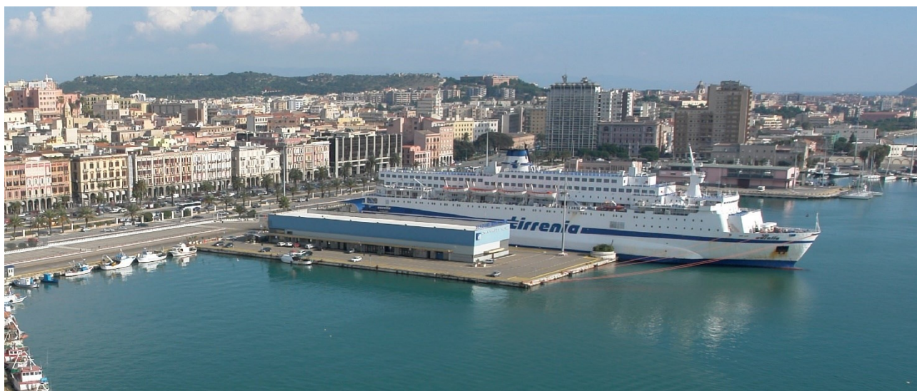
- Edificio adibito a Stazione marittima con ormeggio della nave Ro Ro – pax sul Molo Sanità -
