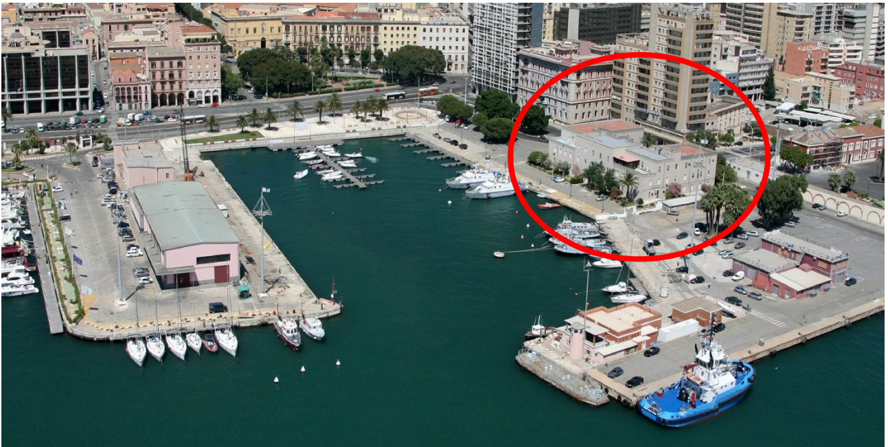
- Edificio da demolire per consentire l'arrivo in quota del tunnel -
