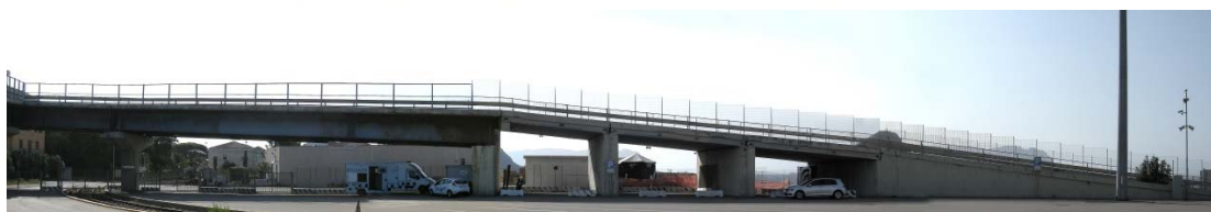
Vista rampa facciata Nord – stato attuale
