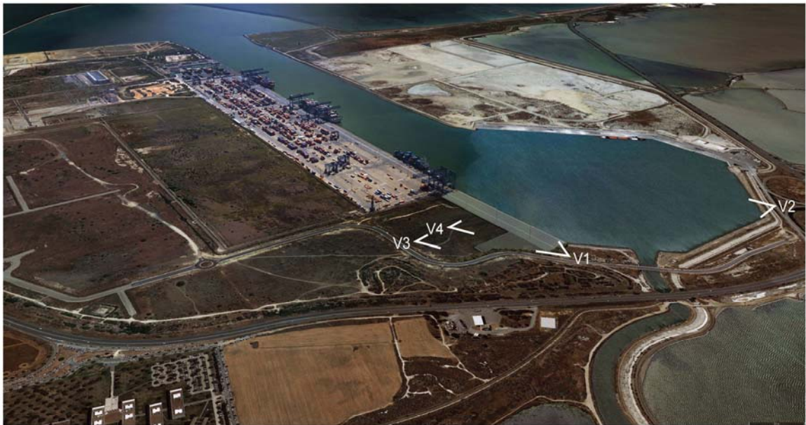
vista aerea da Nord intervento di realizzazione della nuova banchina.
