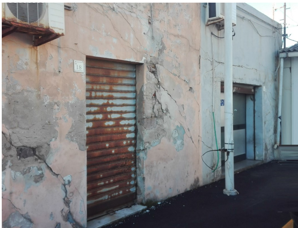
- Foto dei prospetti dei locali da demolire -
